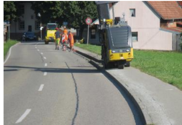
Wiederherstellung Asphalt- oberfläche
