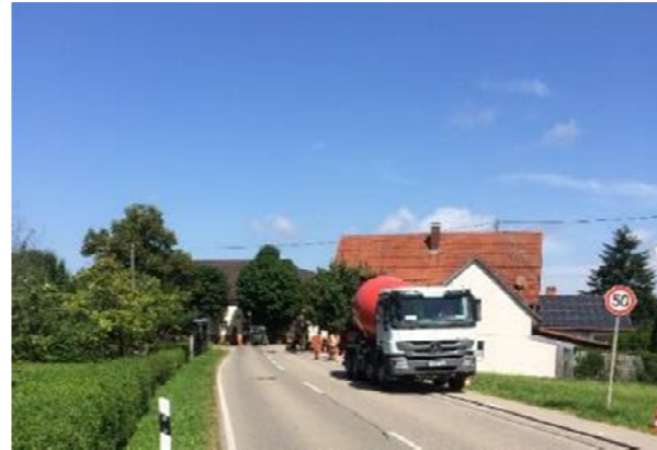
Verfüllen des Fräsgraben
