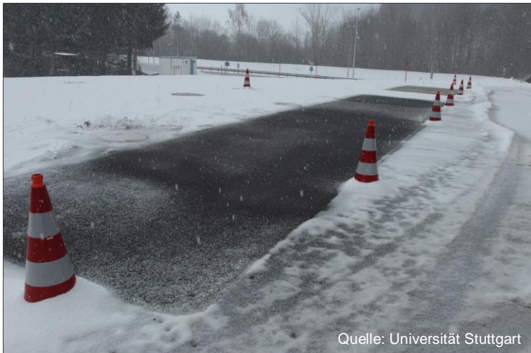
Bild 3: Geothermische Versuchsanlage zur Schnee- und Eisfreihaltung einer Versuchsfläche am Grenztunnel Füssen
