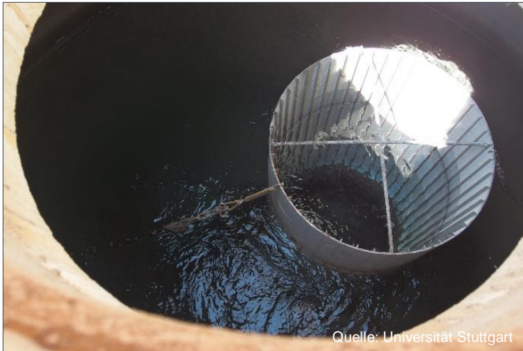
Bild 2: Sammelschacht für das Dränagewasser zur Klimatisierung eines Betriebsgebäudes am Tunnel Rennsteig
